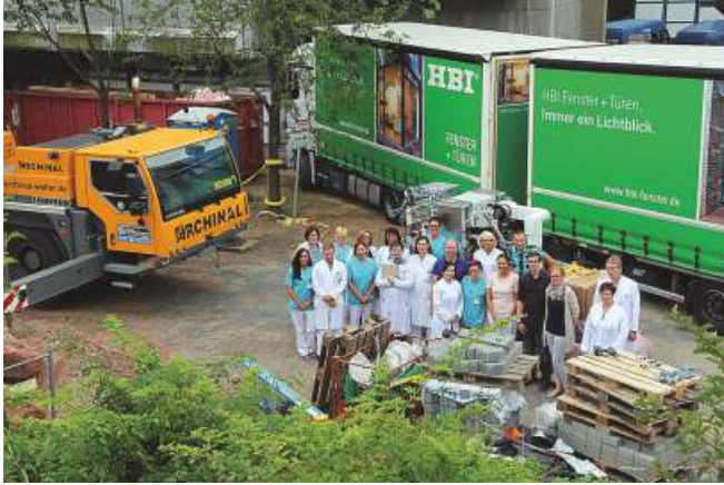
9-monatige Bau-, Test- und Qualitätssicherungsphase
