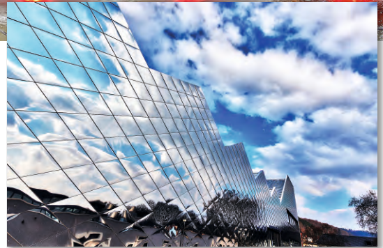
Die Spiegelrouten des neuen Daches sind ein Markenzeichen des Erwin-Piscator-Hauses
