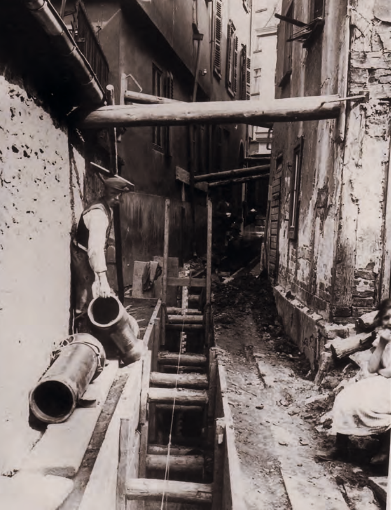
Kanalisationsarbeiten in der Sandgasse um 1900
